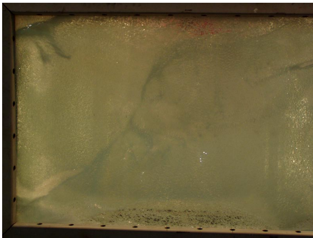
Рис. 12. Стекло разрушено взрывом, но в раме стоит крепко, и осколки не осыпаются
