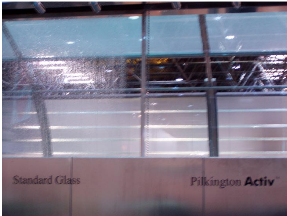
Рис. 2. Вид из окна в дождливую погоду: слева через обычное стекло, справа - через самоочищающееся
