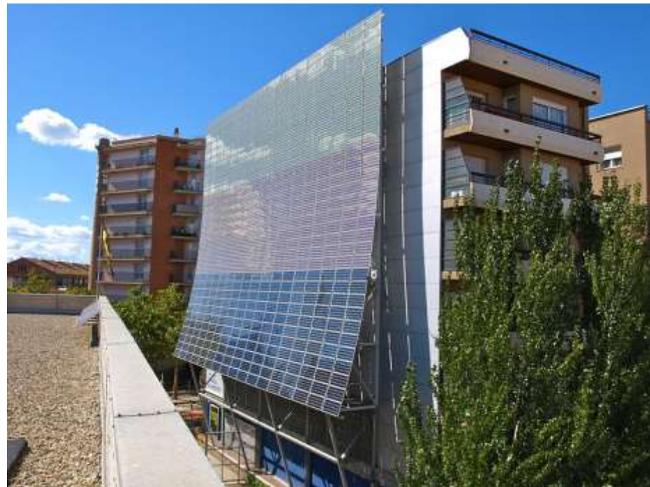
Испания Солнечные батареи в оболочке здания (BIPV, Building-integrated photovoltaics)
